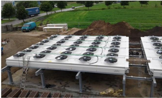
Figur 8.3 – Billede af udeluftkølerne i Tønder.
