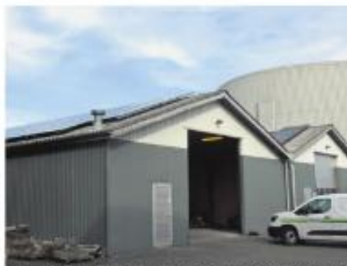
De nye solceller på taget af Brædstrup Fjernvarme skal fremover levere strøm til værket's eget forbrug. Foto: Henrik C. Sandved
